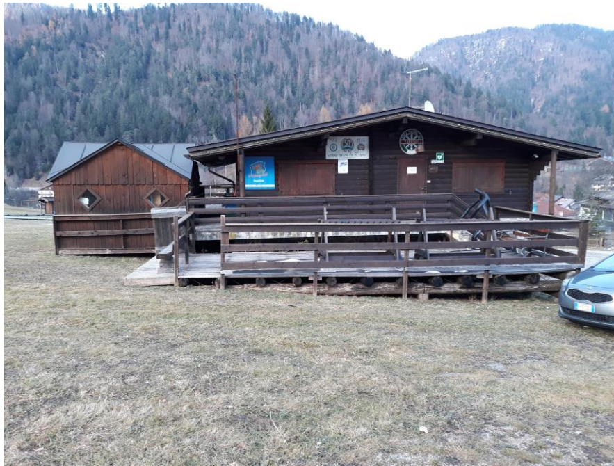
Vista sud-sud-ovest fabbricato esistente
