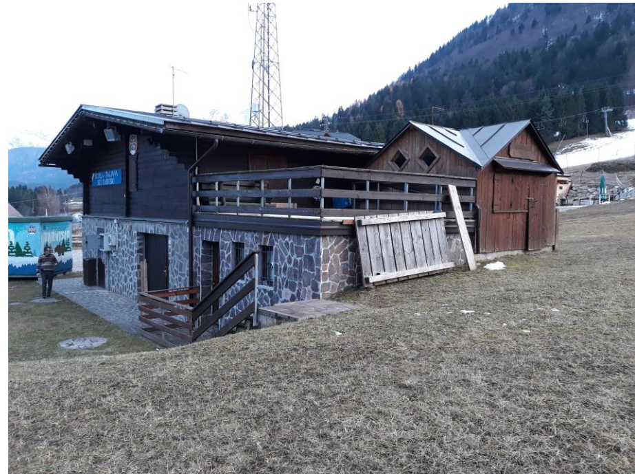
Vista nord-ovest fabbricato esistente
